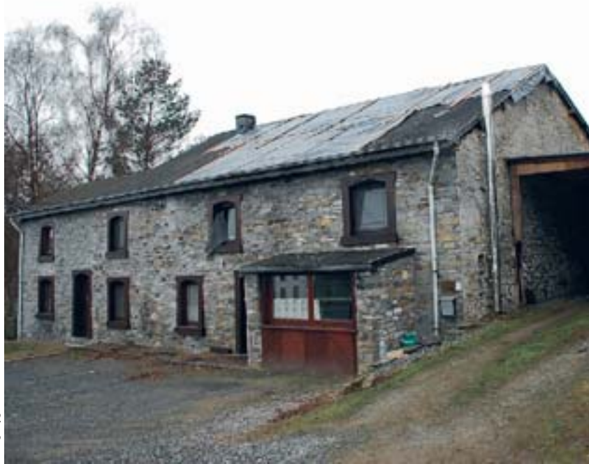
Pour maîtriser l'incendie, les pompiers ont ouvert la toiture pour permettre à la chaleur de s'échapper. Ils y sont retournés pour bâcher.
